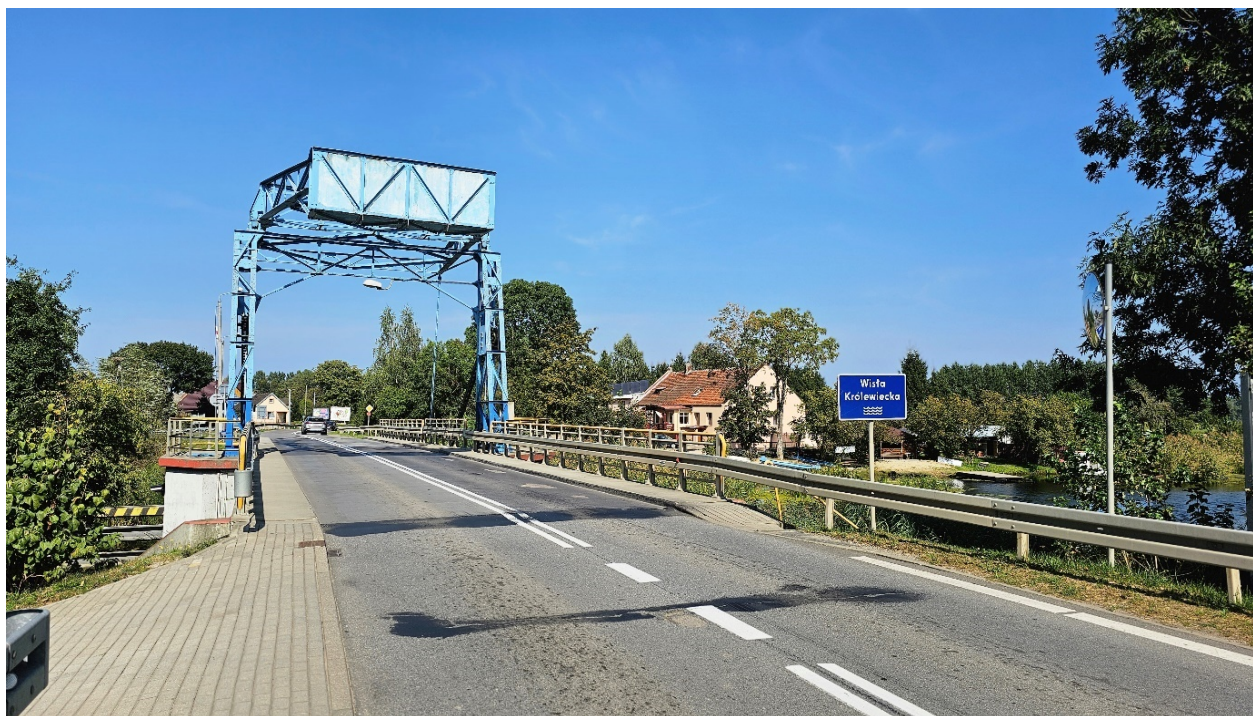
Zdjęcie 18– widok na most zwodzony na rzece Wista Królewiecka.
