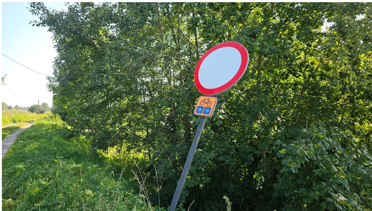
Zdjęcie 15– trasa rowerowa po wale przeciwpowodziowym nr 10 oraz 13
