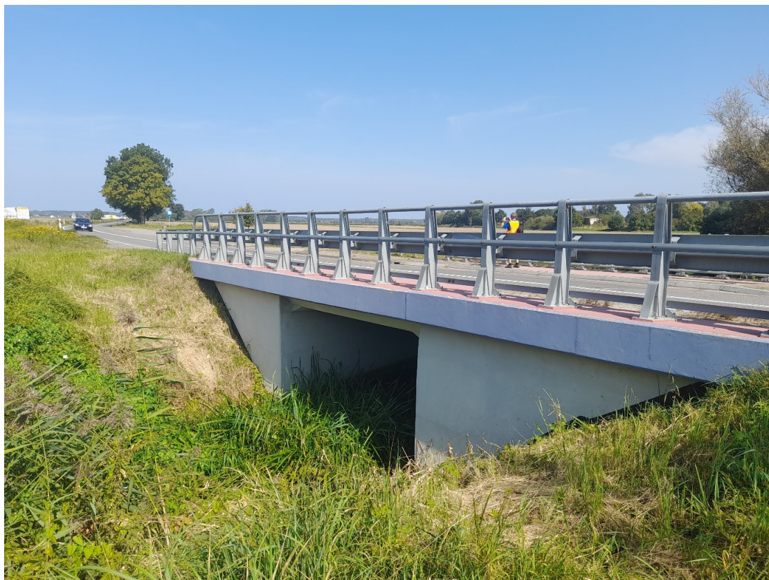
Zdjęcie 19– obiekt inżynierski na DW 502
