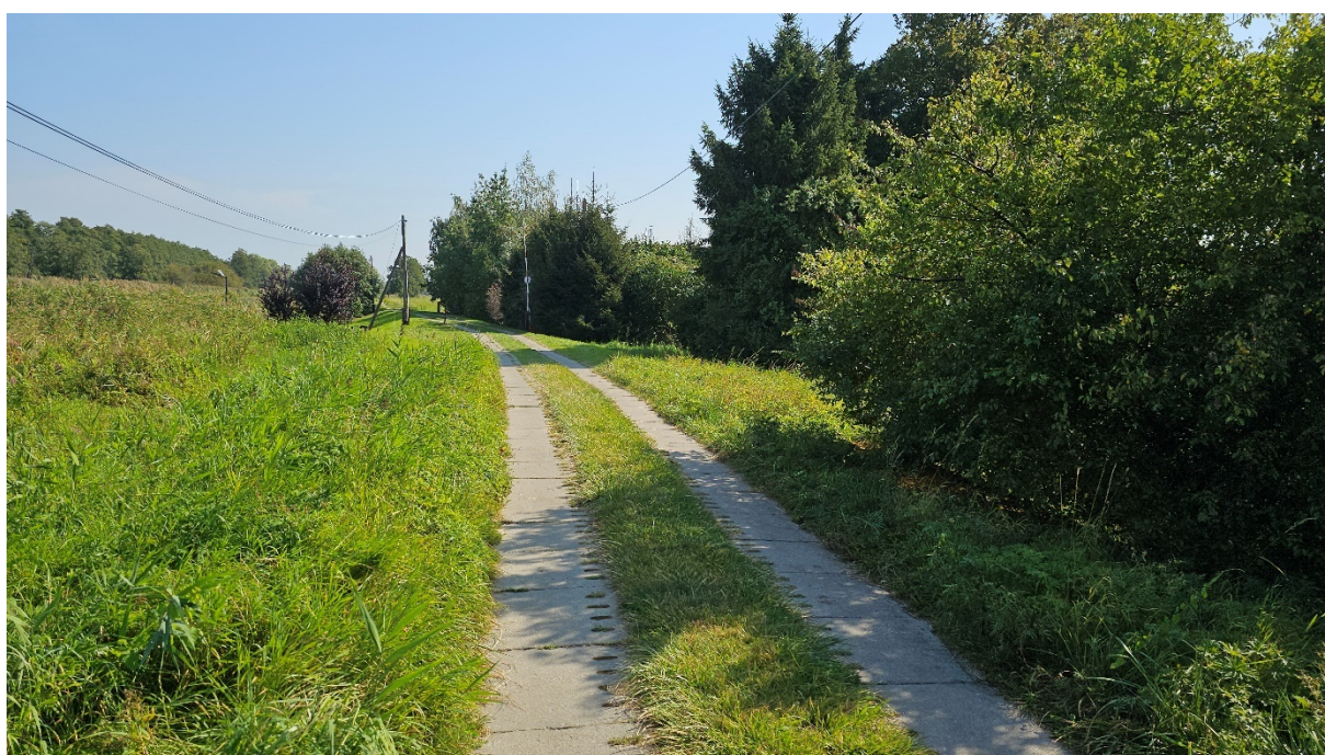
Zdjęcie 14– trasa rowerowa po wale przeciwpowodziowym nr 10 oraz 13
